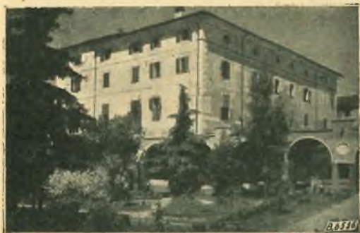
Lombriasco (Torino). — Il vecchio fabbricato.
